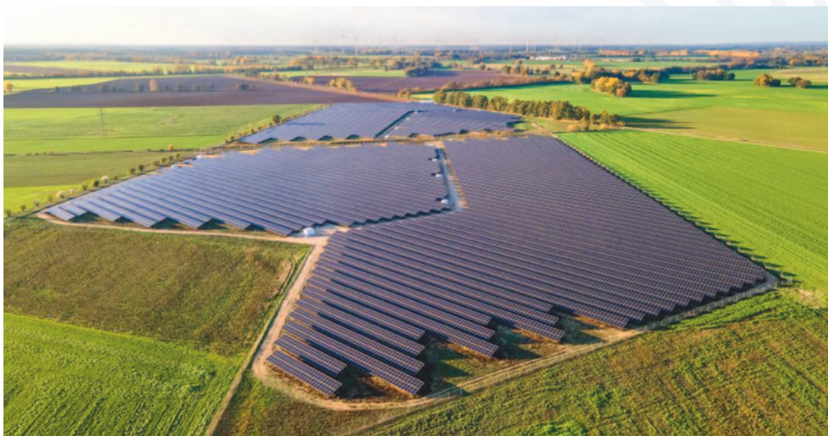
21.1 MW, Bad Liebenwerda, Brandenburg, Germany.
