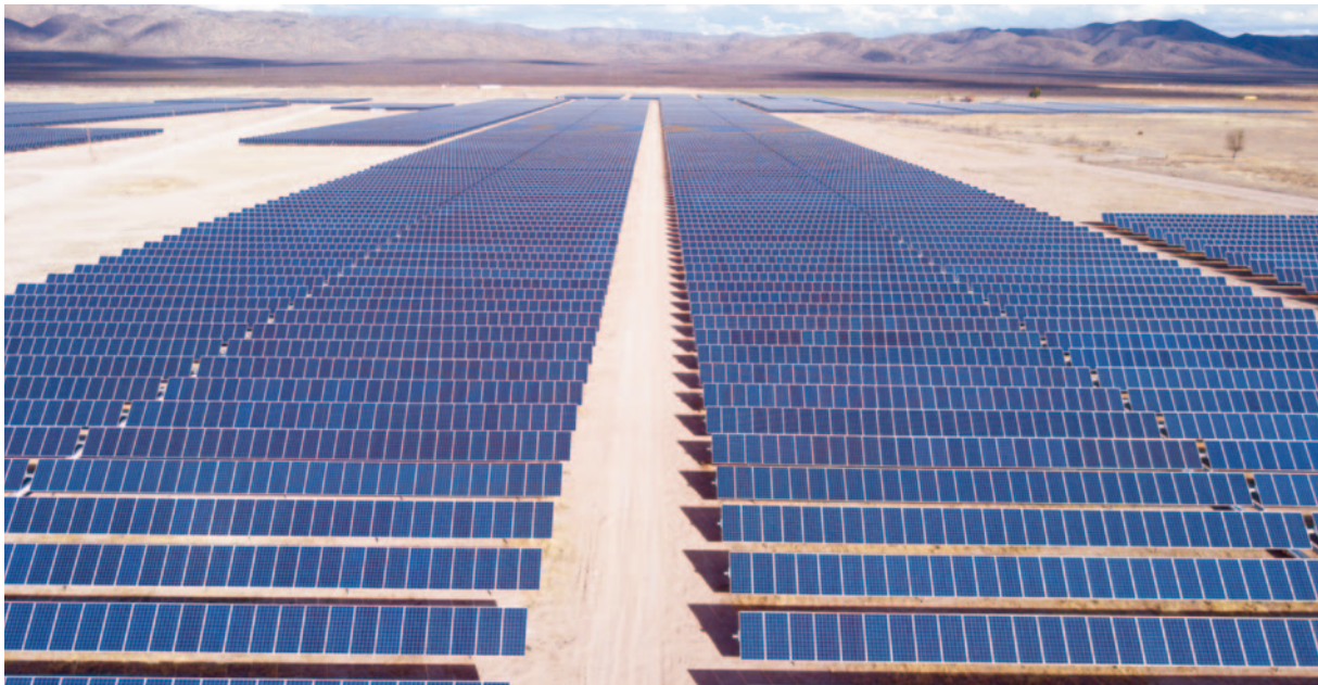
36 MW, Torreoncitos solar park, Jiménez, Chihuahua, Mexico.
